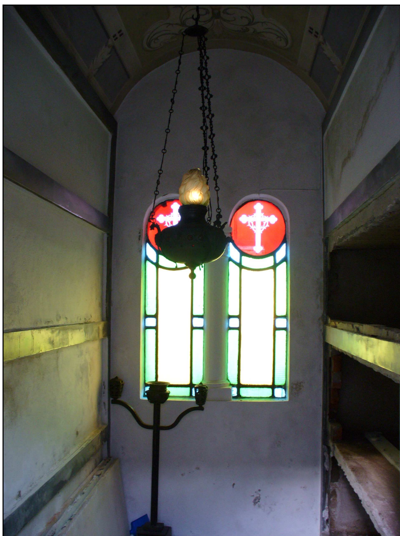
INTERNO – VISTA PARETE DI FONDO
